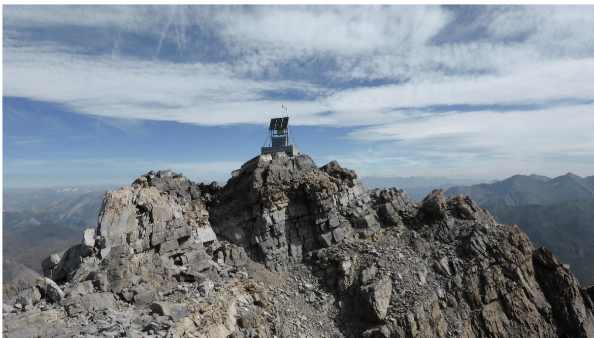
Pointe Centrale vue depuis la Pointe Sud
